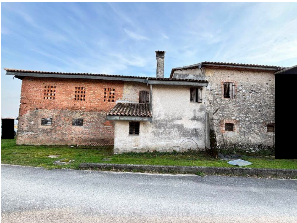
FOTO 5 • vista da Nord
