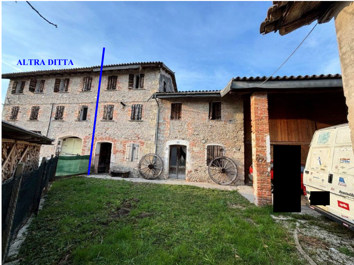
FOTO 1 • vista da Sud
